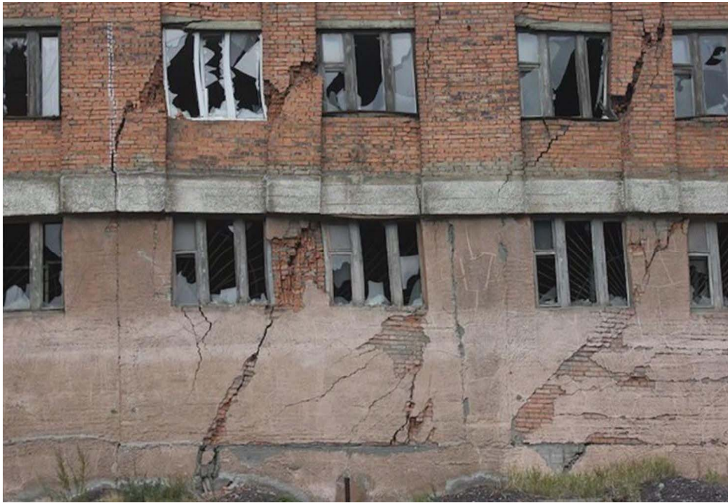
Рис.1 Развитие трещин в результате проявления просадки оттаивающего грунта в основании здания в гор. Норильск
