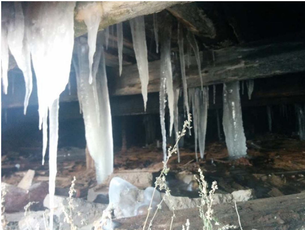
Рис.2. Последствие аварийной утечки из теплосети в проветриваемом подполье под зданием, возведенным по I принципу использования многолетнемерзлых грунтов в качестве оснований.
